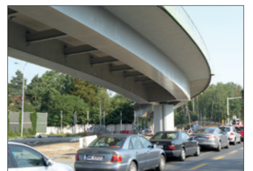
Wiaduktem ul. Żołnierskiej nad torami do Rembertowa pojedziemy w przyszłym roku
